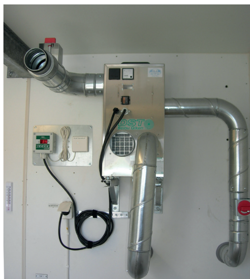
Déshumidificateur de type DR-010B installé dans une unité de pression par étages raccordé au EH4
