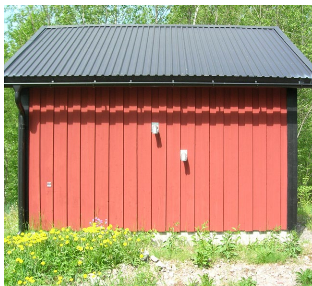
L'air humide est extrait du poste de surpression tandis que l'air extérieur entre pour régénérer l'air du local
